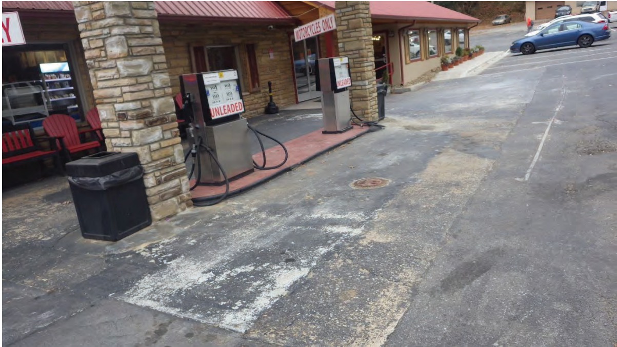
UST fill port
