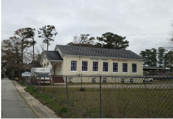
Parcel 041 / 040 Building A
